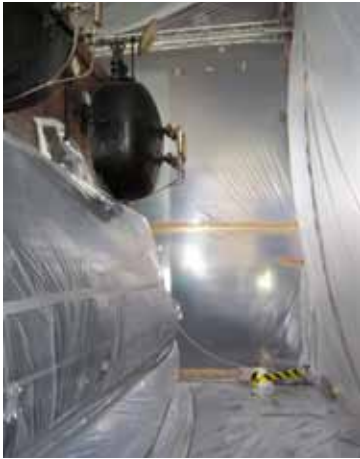
Figura 1. Confinamiento a presión negativa
